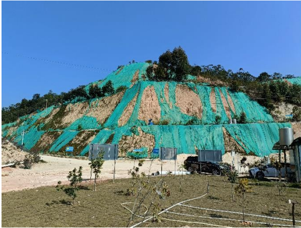
矿区口边坡绿化
