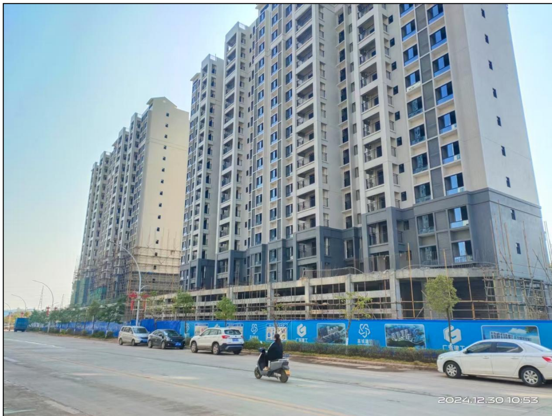
项目建设区现状(A区) 图一
