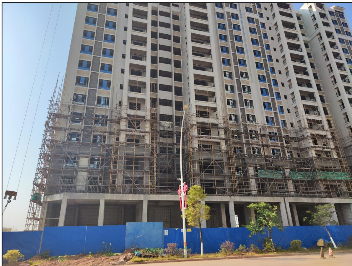
项目建设区现状(A区) 图二
