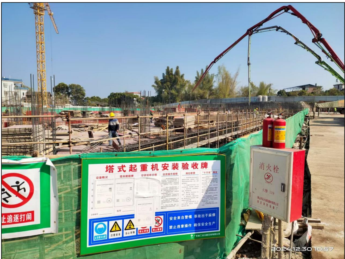
项目建设区现状(B区) 图六
