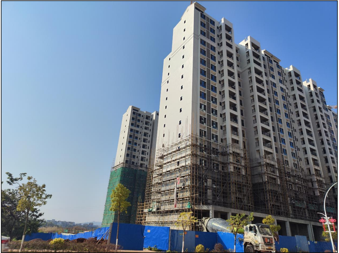
项目建设区现状(A区) 图三
