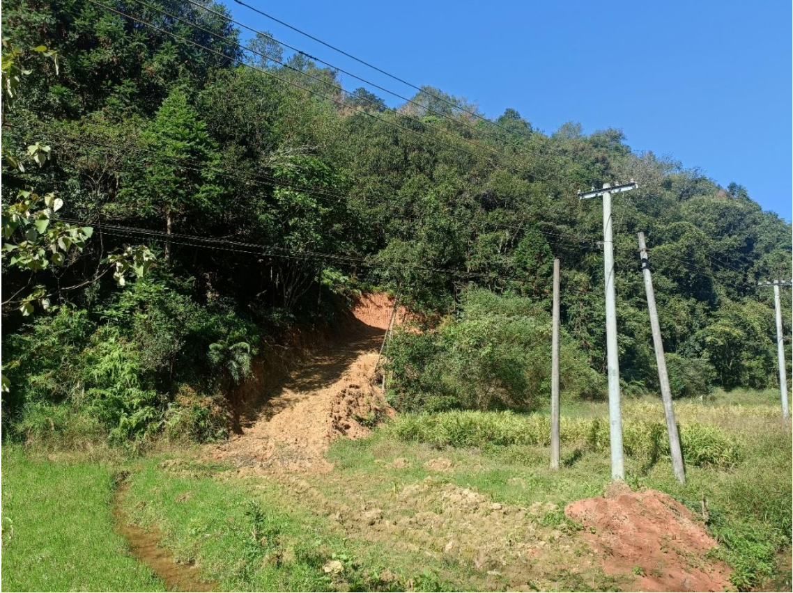
图4 一号支洞出口现状
