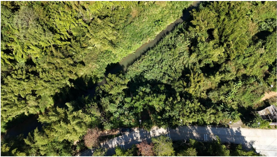
图6 石马河拟建拦河水陂位置现状
