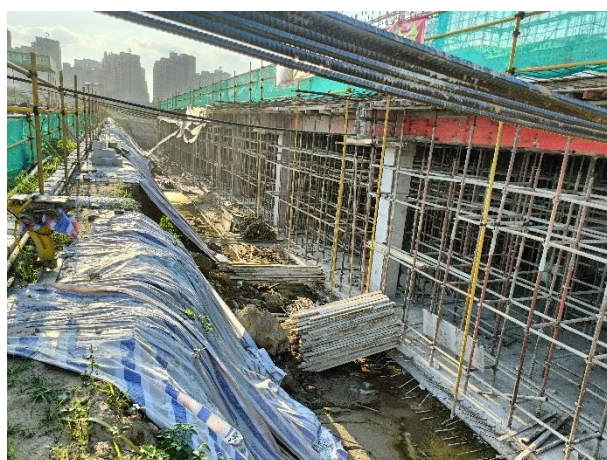
照片4 地下室顶板施工
