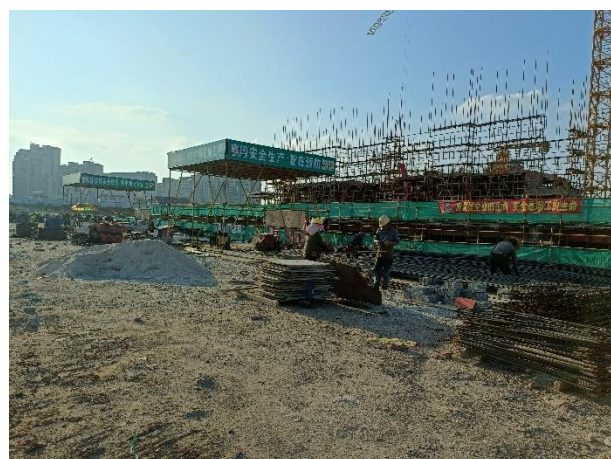
照片5 钢筋加工场
