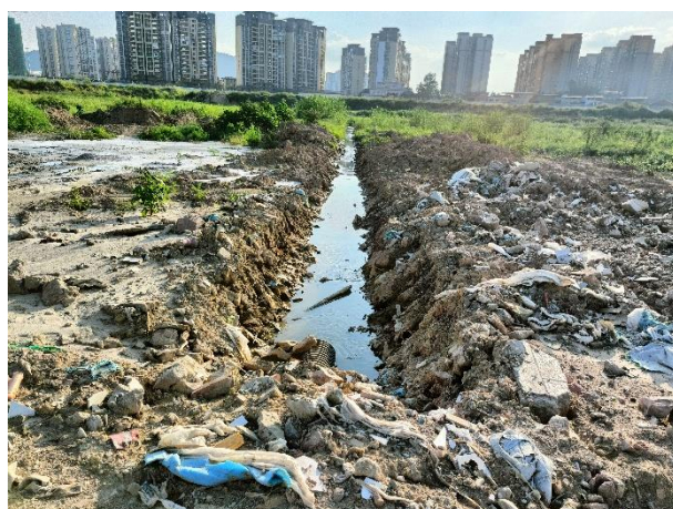
照片6 土质排水沟
