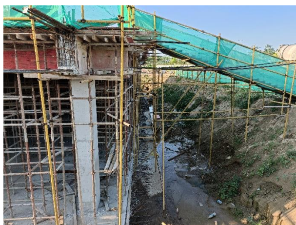
照片8 基坑周边排水沟
